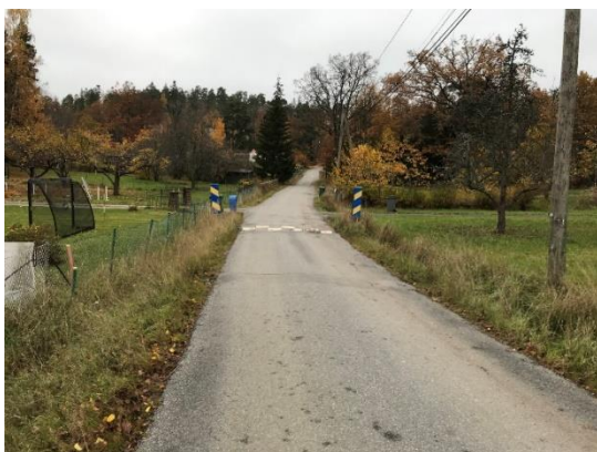
Figur 19. Befintlig hastighetsdämpande åtgärd med upphöjning på Fasanvägen.
