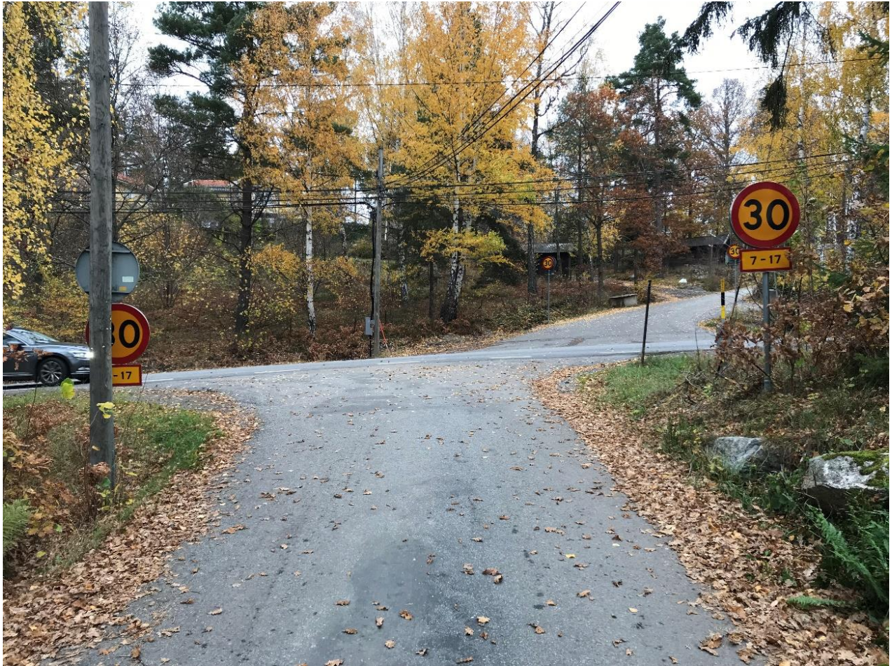
Figur 5. Korsningen Fasanvägen/Breviksvägen/Rödstjärtvägen, sett från Fasanvägen.
