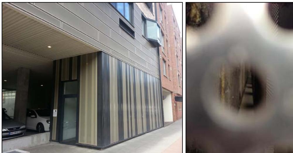
Figur 6. Byggnad med absorberande fasadpaneler. Till höger en närbild på perforeringen med mineralullsskivor bakom.
