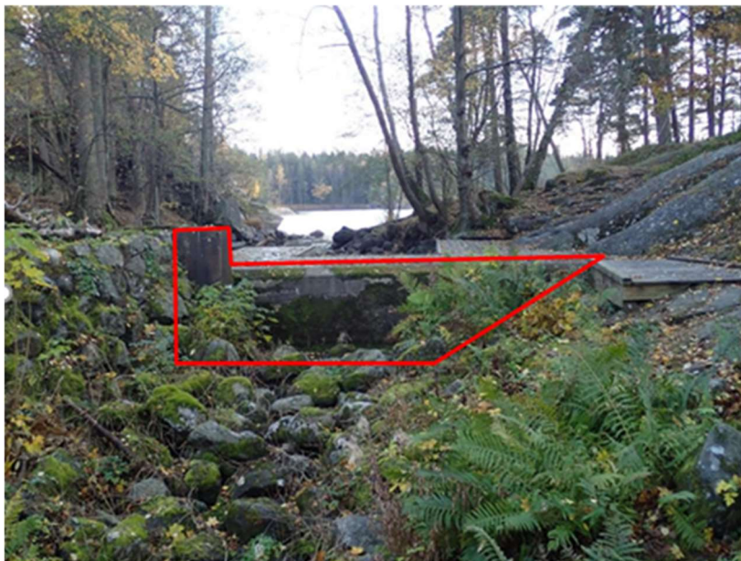
Figur 7. Anslutningsdamm vid kanotplatsen. Tröskeln är i betong. Norconsult 2016.
