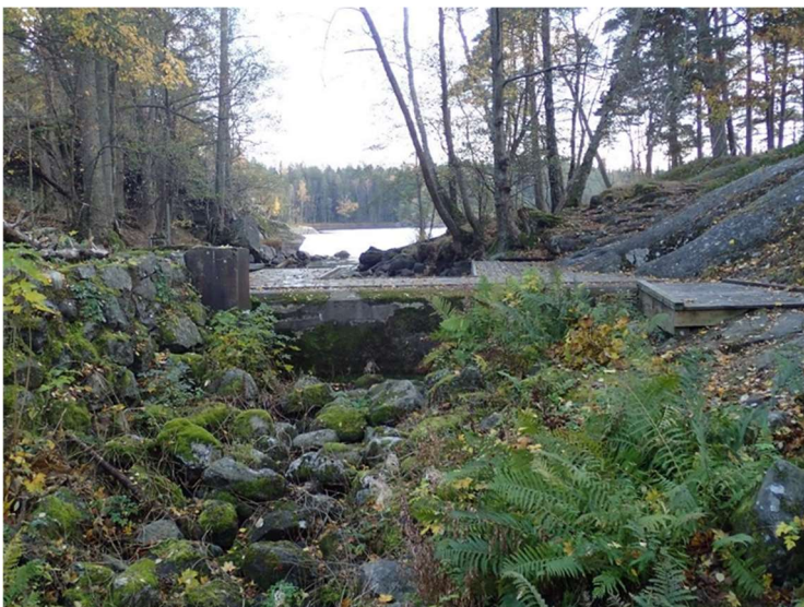
Figur 5. Kvarndammen har ett utskov inrett med två spettluckor. Norconsult 2016.
