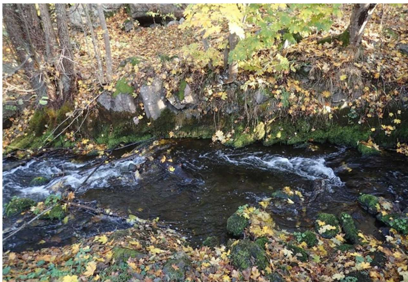
Figur 8. Nedströms utskovet vid kvarndammen är fåran sprängd. Norconsult 2016.
