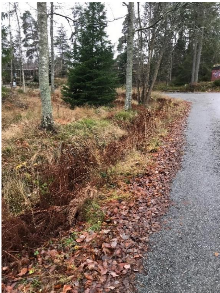
Figur 21. Anslutning från etapp 13 till etapp 14 vid korsningen Talgoxevägen/Entitevägen. Fotot tagit mot sydväst (Foto: Sweco, november 2019).
