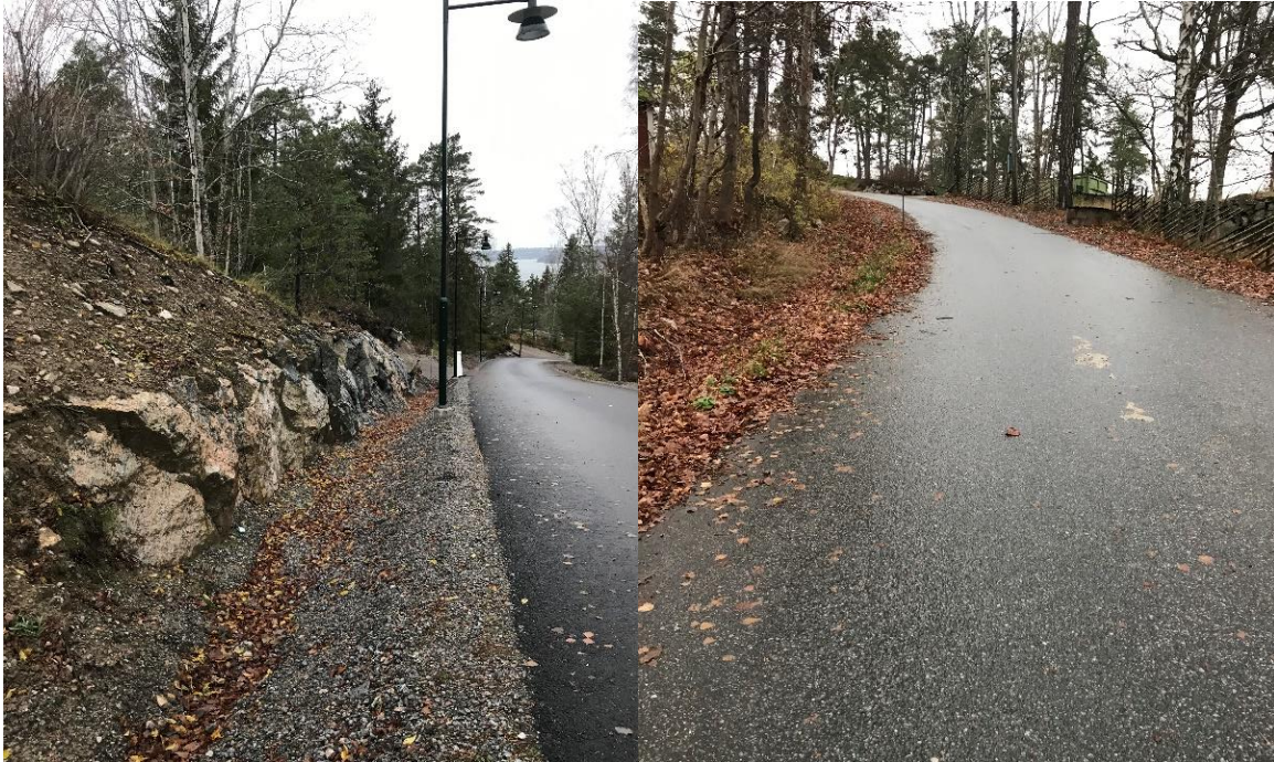
Figur 5 Plangränser på Rödstjärtsvägen. Fotot till vänster visar nyanlagda diken och väg på Rödstjärtsvägen i etapp 10, mot norr. Fotot till höger visar södra delen av Rödstjärtsvägen som är i etapp 13 och inte har byggts om. Rödstjärtsvägen är brant, med mer än 20% lutning. (Foton: Sweco, november 2019).
