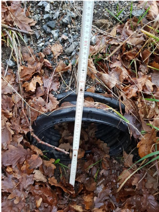
Figur 10 Trumma ungefärlig dimension 300 mm i nyanlagda diken under infart i Rödstjärtsvägen (etapp 2 till 6).
