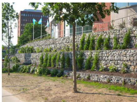
Exempel på gabionmur.
