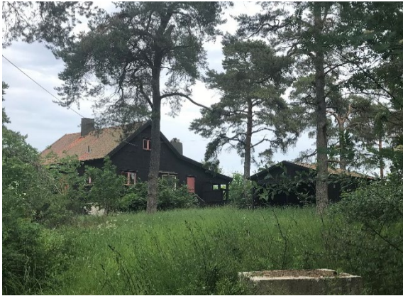
Fotografi visar befintlig huvudbyggnad och garage.
