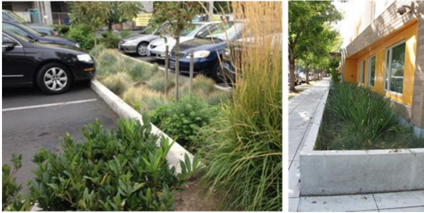
Figur 16. Bildexempel på nedsänkt (t.v.) resp. upphöjd (t.h) växtbädd i anslutning till parkeringar resp. längs en husvägg. Foto: WRS AB.
