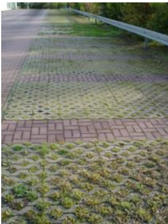
Figur 21. Hålstensbeläggning på parkering. Foto: WRS AB.
