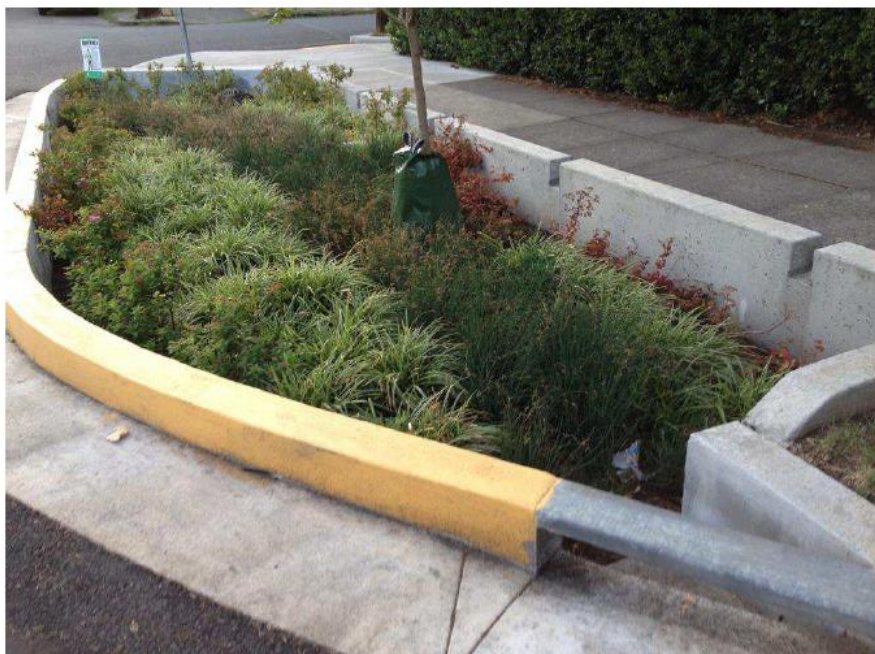
Figur 25. Bildexempel från Portland på nedsänkt växtbädd med träd och andra växter dit dagvatten från väg och trottoar leds. Foto: WRS AB.
