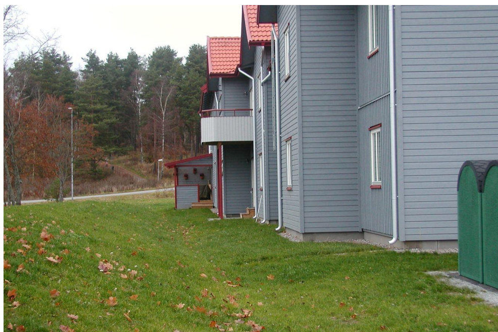
Figur 19. Notera att marken sluttar bort från huset. Där gräsmattan möter den högre terrängen finns ett lågområde/svackdike som kan avleda stora vattenmängder vid extrem nederbörd och där vattnet även tillåts "stå" och infiltrera under längre tid. Foto: WRS AB.
