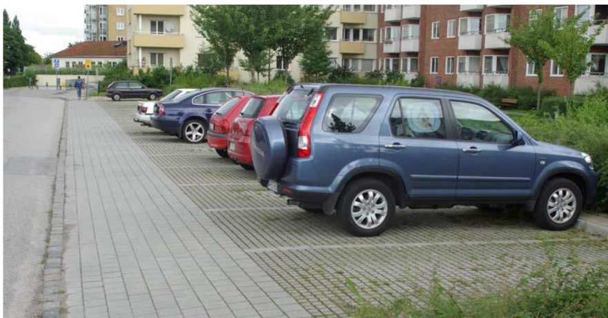
Figur 27. Exempel på parkering med genomsläpplig beläggning. Foto WRS AB.
