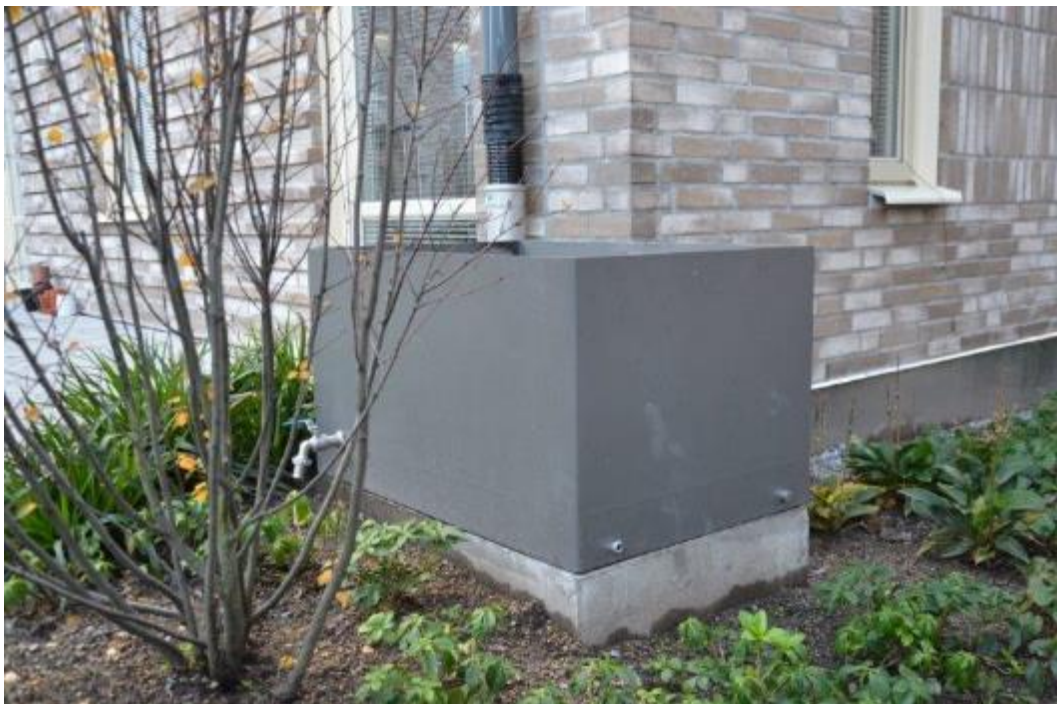
Figur 17. Insamling och lagring av takdagvatten i en tank för kommande bevattning, exempel från Norra Djurgårdsstaden. Foto: WRS.
