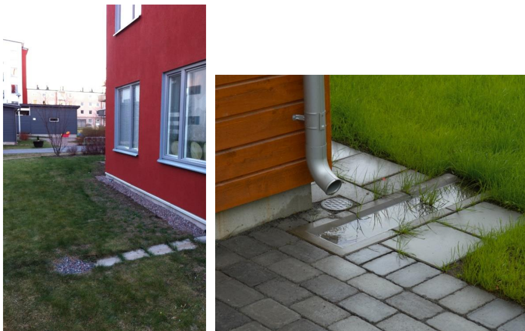
Figur 18. Exempel på takvatten som avleds via rännal till mindre stenkista respektive gräsmatta. Foto WRS (tv), www.steriks.se (th).
