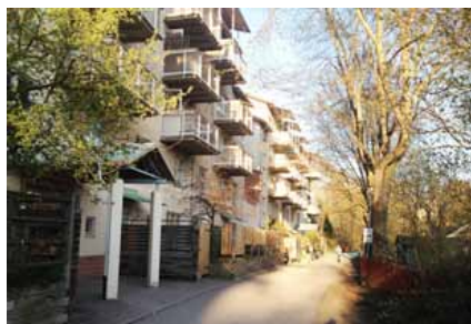
Figur 18. Kvarter med angränsande g/c-vägar ger en tydlig gräns som säkrar allmänhetens tillgänglighet. Referens: Zinkens väg, Stockholm
