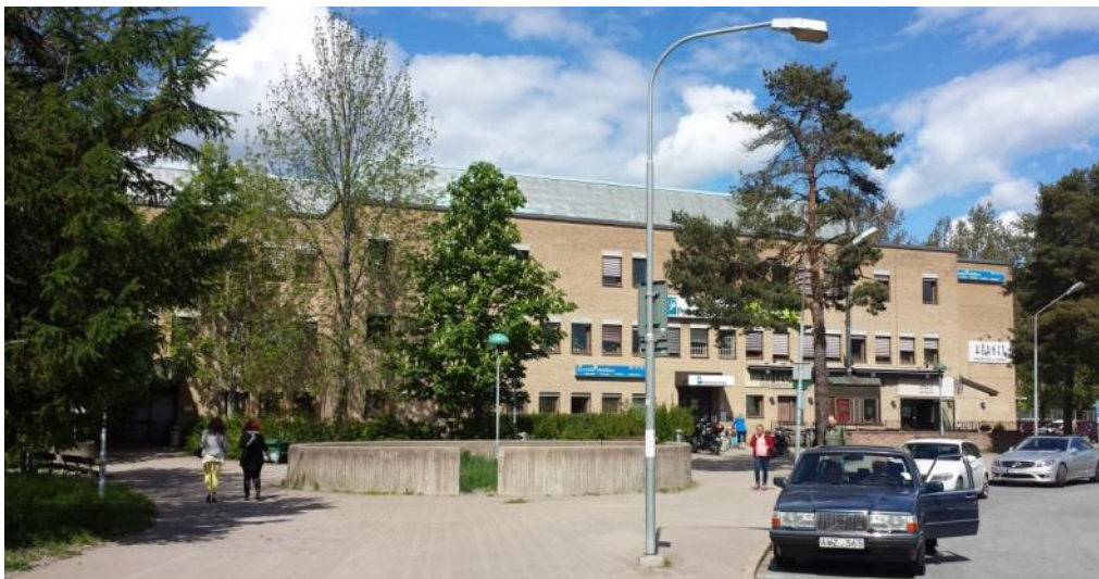
Befintlig byggnad inom planområdet sett från söder
