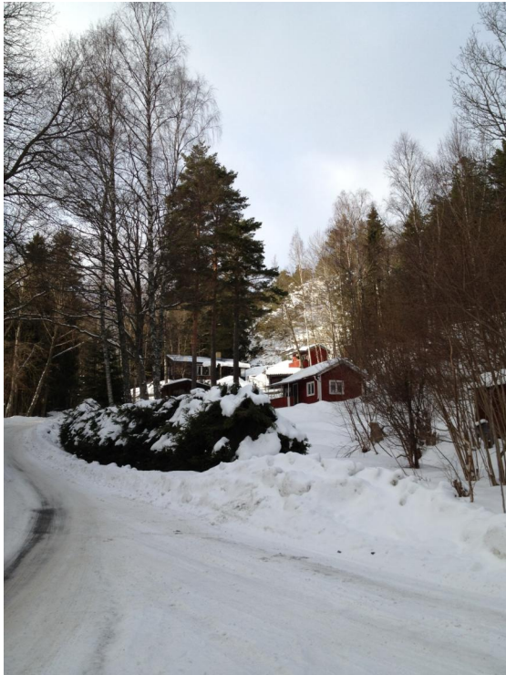
1-145 hög bergslänt bakom huset
