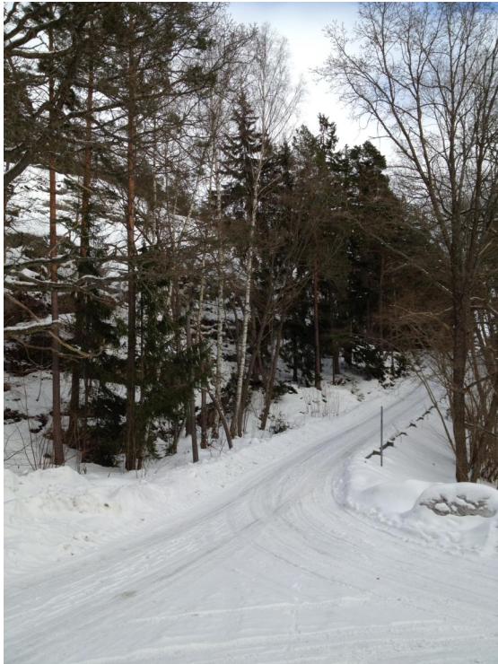
1-170 stabil hög bergslänt vid Noretvägen
