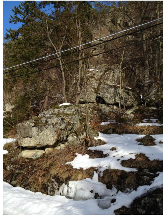
Dy6-1 stora block vid väggen från bergslänt
