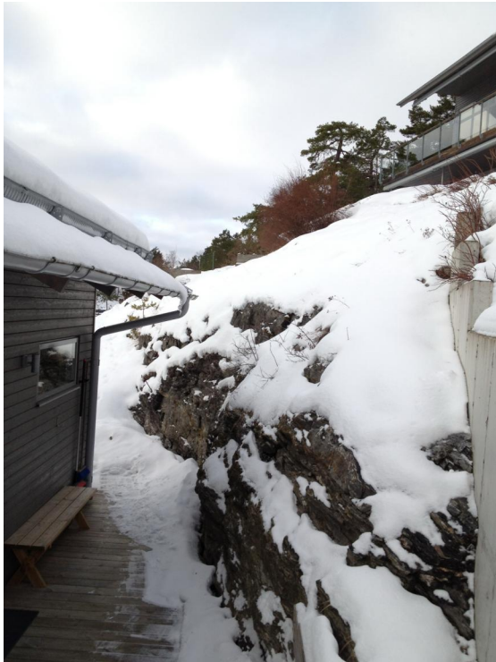
1-76 stabil bergvägg bakom bastu
