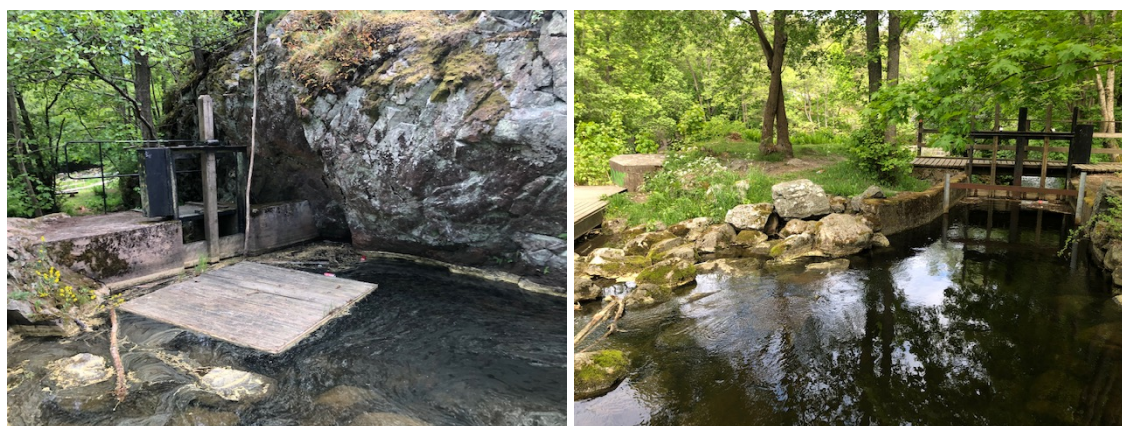
Figur 2. Dammluckor vid Nyfors. Krondammen till vänster och Kvarndammen till höger.
