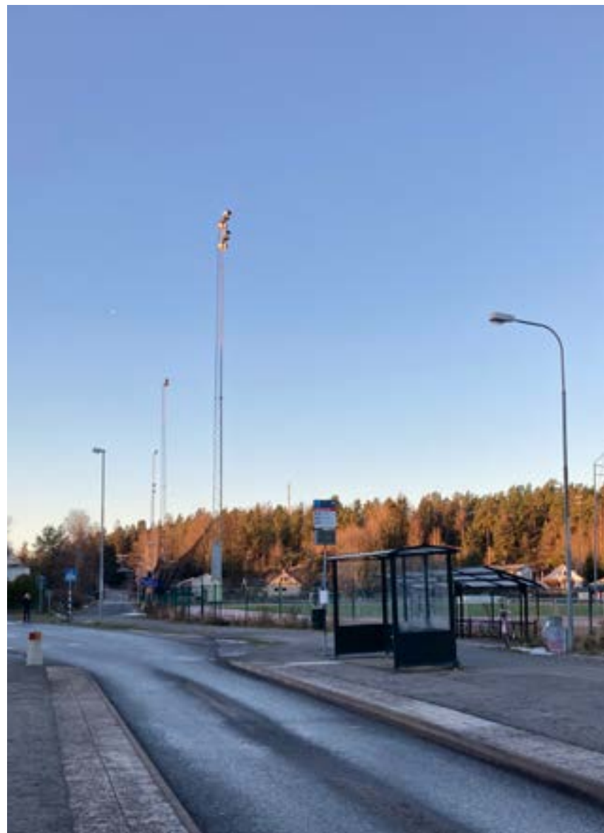
Timglashållplats för ökad trafiksäkerhet på lokalgator.
