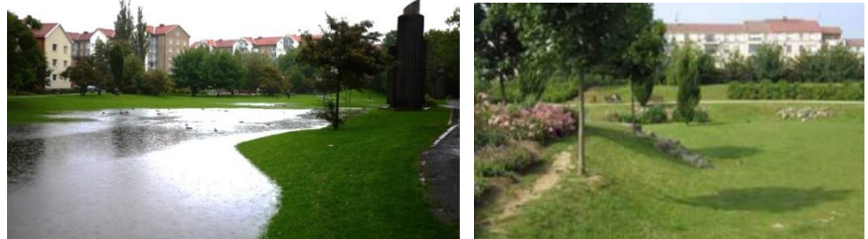
Figur 17. Två foton på torrdammar: till vänster en vattenfylld (Boverket, 2019) och till höger en tom damm (Uppsala Vatten, u.å).
