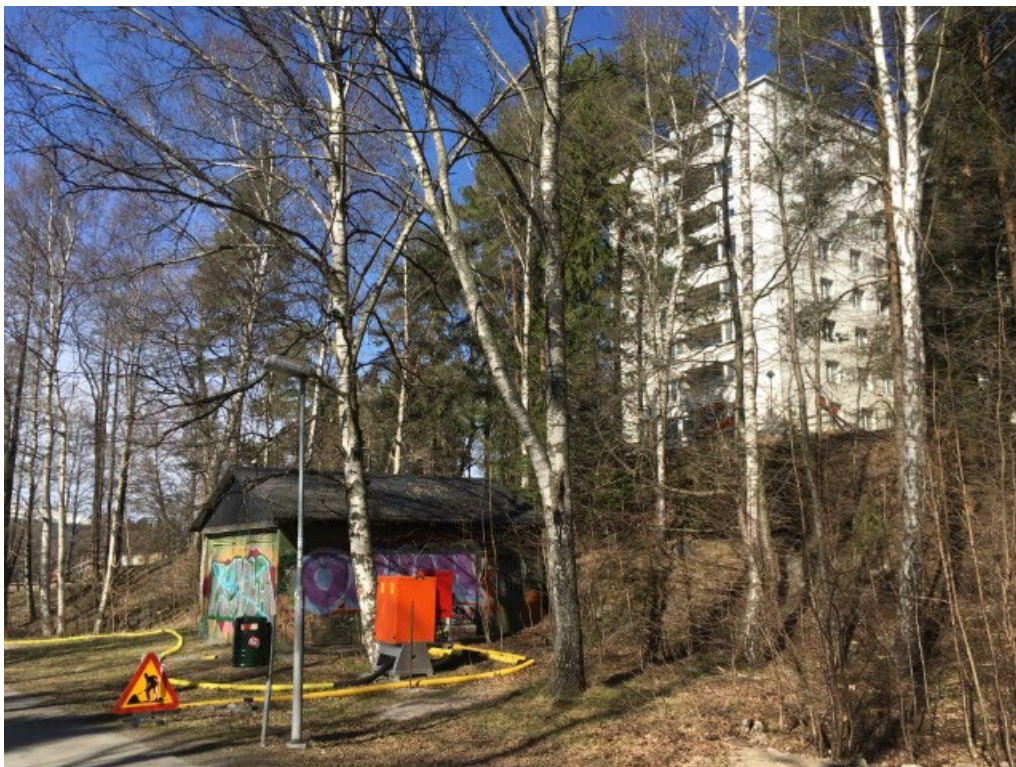
Befintlig markanvändning med Tyresö bostäders fastighet Gösen 1 i bakgrunden.
