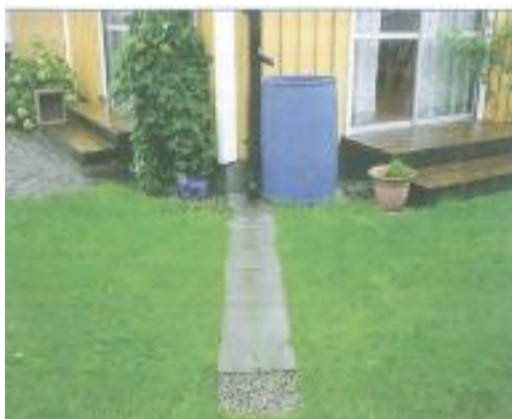
Figur 10 Stuprörsutkastare med tät vattenavledare Svenskt vatten P105 figur 9:4.
