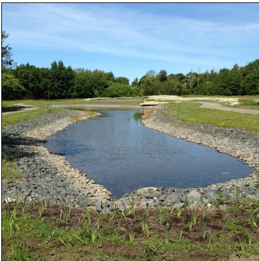
Figur 7. Exempel på dagvattendamm i Trönninge i Varberg. Foto: Norconsult
