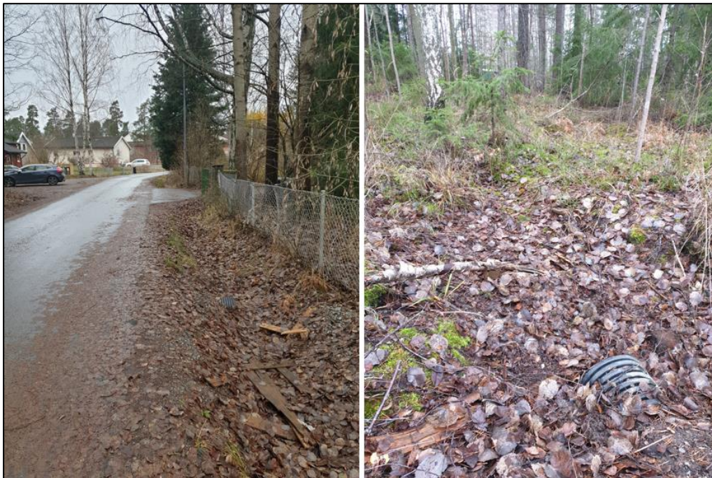
Figur 12. Amaryllisvägen samt trumma som avleder dagvatten från vägdike till grönyta inom planområdet
